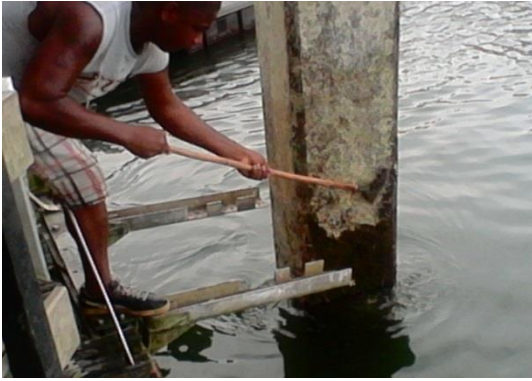
Limpieza subacuática y exterior muelle flotante
